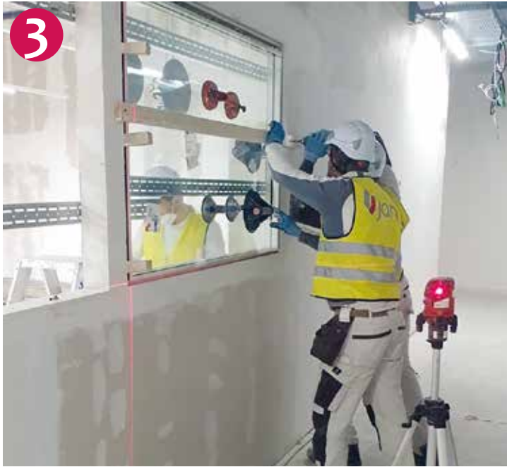
Pose d'un verre coupe-feu EI60 selon état de la technique.
