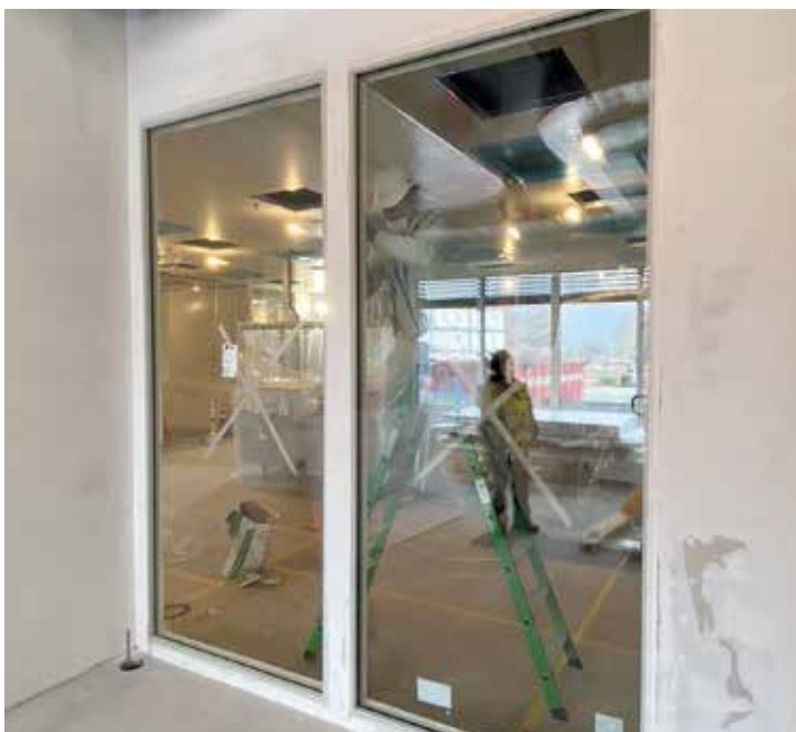
Remplissage des vitrages au mortier colle RF1 pour le scellement.
