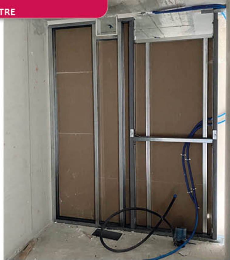
Complément d'aménagement ajouté à une cloison légère d'appartement avec sous-construction appropriée pour permettre l'absorption de la charge imposée par les installations sanitaires.
