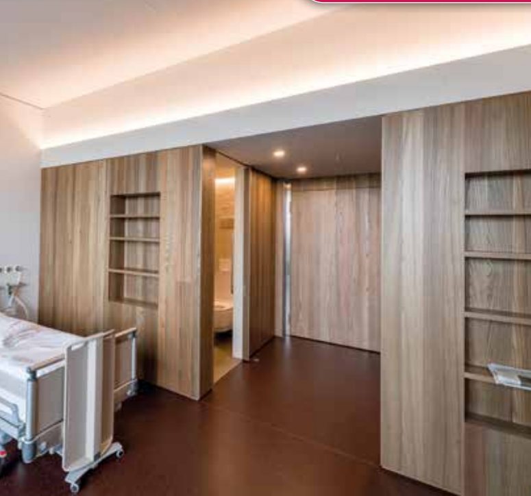
Le panneau incliné pour l'éclairage indirect est également réalisé au moyen de systèmes de construction à sec en plâtre.
