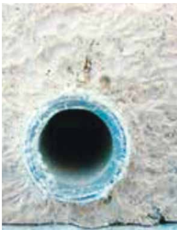
CAF enrobage parfait des tuyaux de chauffage
