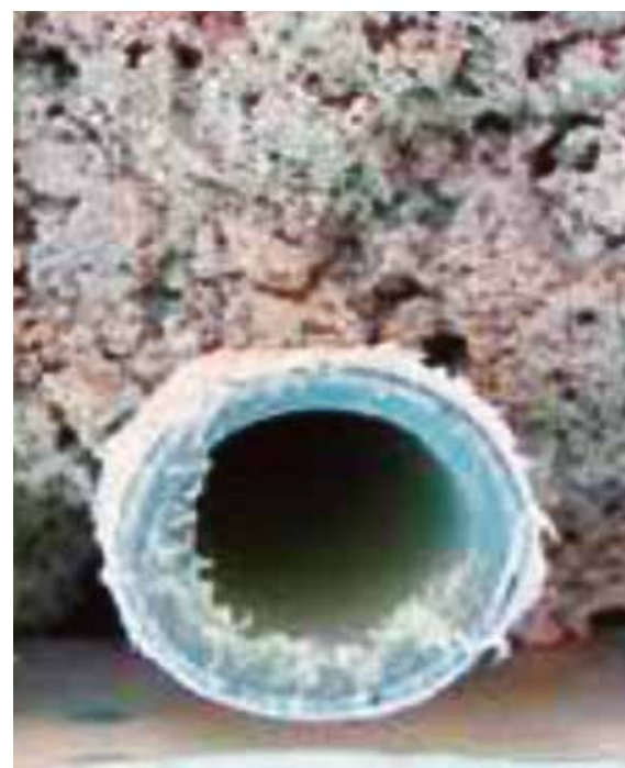
Chape traditionnelle : l'enrobage n'est pas homogène donc, perte de chaleur.
