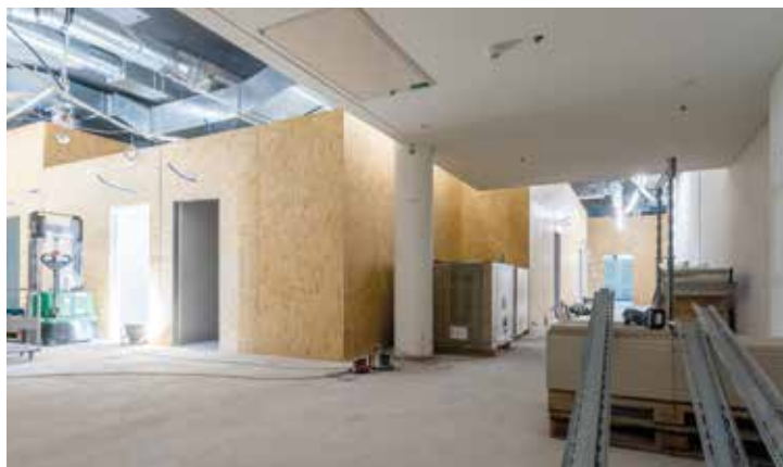
®Salles de réunion pendant le montage et après l'achèvement de l'ossature métallique en acier léger.
