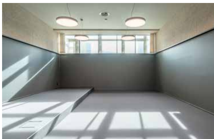
Des salles d'audience fonctionnelles: les cloisons sèches isolées avec des profilés spéciaux empêchent la transmission du bruit.
