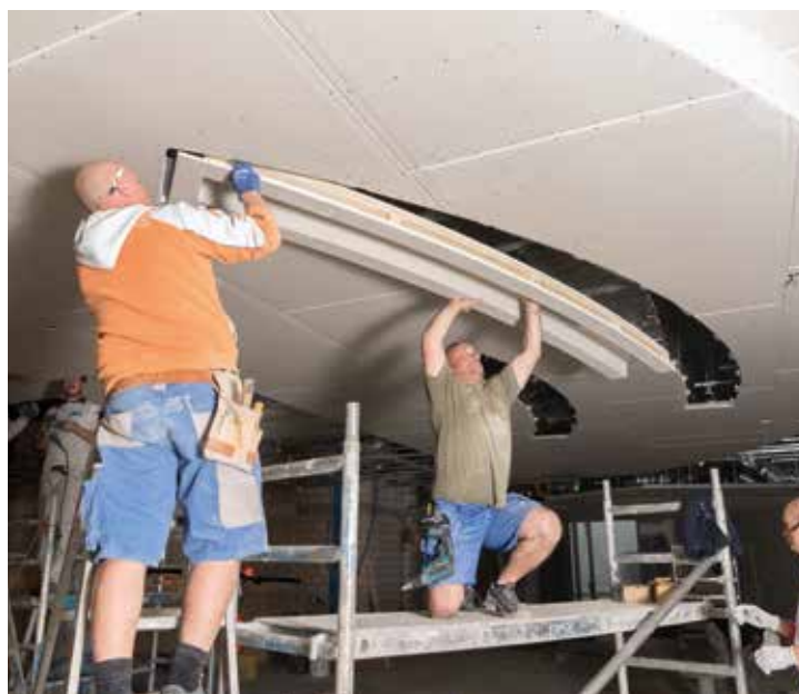
Une fois terminés, les éléments préfabriqués ont été encastrés pièce par pièce dans les ouvertures.
