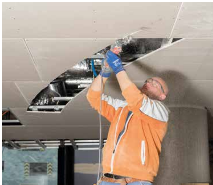
Avant le montage, les plâtriers constructeurs à sec ont découpé des ouvertures dans le plafond de plaques perforées.
