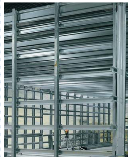
Les structures métalliques de Mégastil
