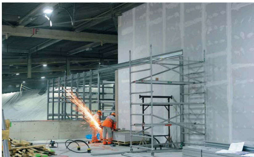
Création d'une nouvelle halle à l'aide des éléments Mégastil de Rigips
